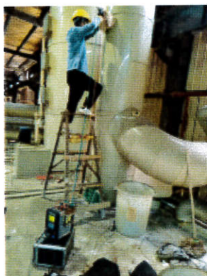
湿法车间有组织排气筒
