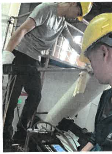
湿法车间工艺废气（脱氮炉）
